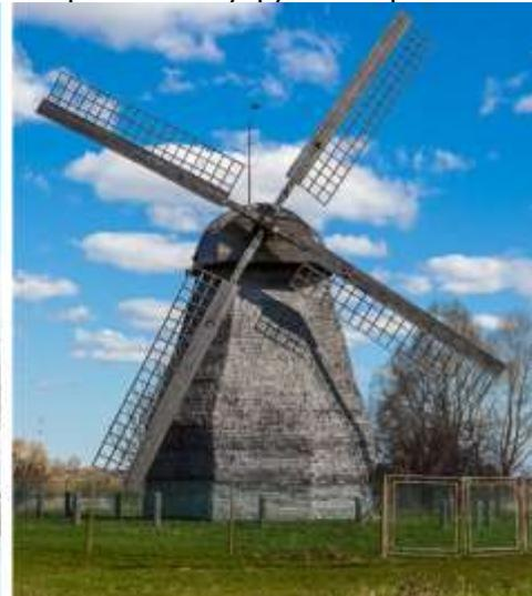
Верхняя поворотная часть мельницы-шатровки могла быть восьмигранной с шатром, прямоугольной с двускатной кровлей или иметь форму полусферы. Её вместе с крыльями вращают при помощи четырех воротил или специального механизма внутри воробины.
